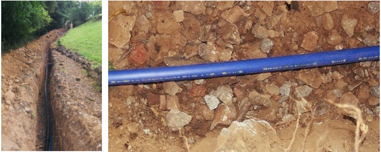
Bild 8: Versuchsstrecke (Länge 300 m) mit sandbettloser Verlegung von Rohren aus Polyethylen in steinigem Boden (Kalksteinfelsen) unter Wiederverwendung des Aushubs
